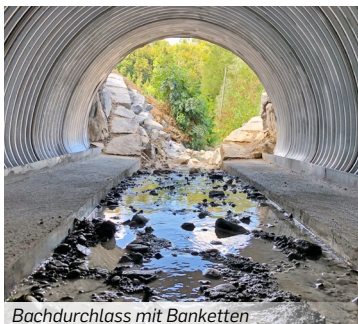
Bachdurchlass mit Banketten
